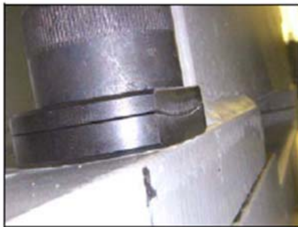
Figure 2 : Inspection des rondelles/boulons du contrepoids
