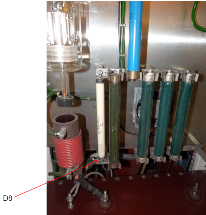
Figure 1 : Emplacement de la diode D8
